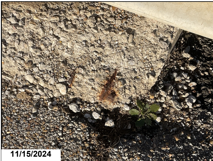
Bent 3 left curb rebar 11-15-2024
